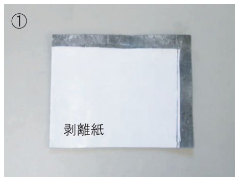
①カプラーの大きさに合わせてカットする。 ※カプラー外周より10mm以上大きくカットします。 ※剥離紙を残すとシワを防ぐ事が出来ます。
