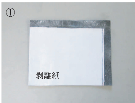
①カプラーの大きさに合わせてカットする。 ※カプラー外周より10mm以上大きくカットします。 ※剥離紙を残すとシワを防ぐ事が出来ます。
